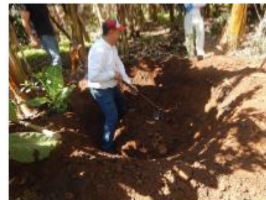
25. Abertura de um círculo escavado no solo, com cerca de 2,0m de diâmetro
